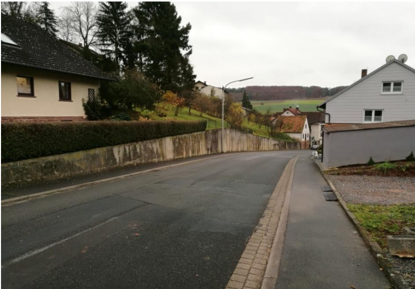
Betonmauer an Frankenstraße
