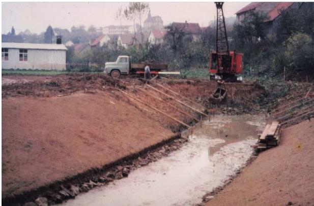
Ab 1965 Hochwasserfreilegung zum Schutze des Klosters. Hierbei musste beachtet werden, dass die Klosterkirche auf Eichenpfählen steht und diese weiterhin unterhalb des Grundwasserspiegels liegen müssen. Gleichzeitig Beginn der Restaurierungsarbeiten am Prälaten- und Konventbau.
